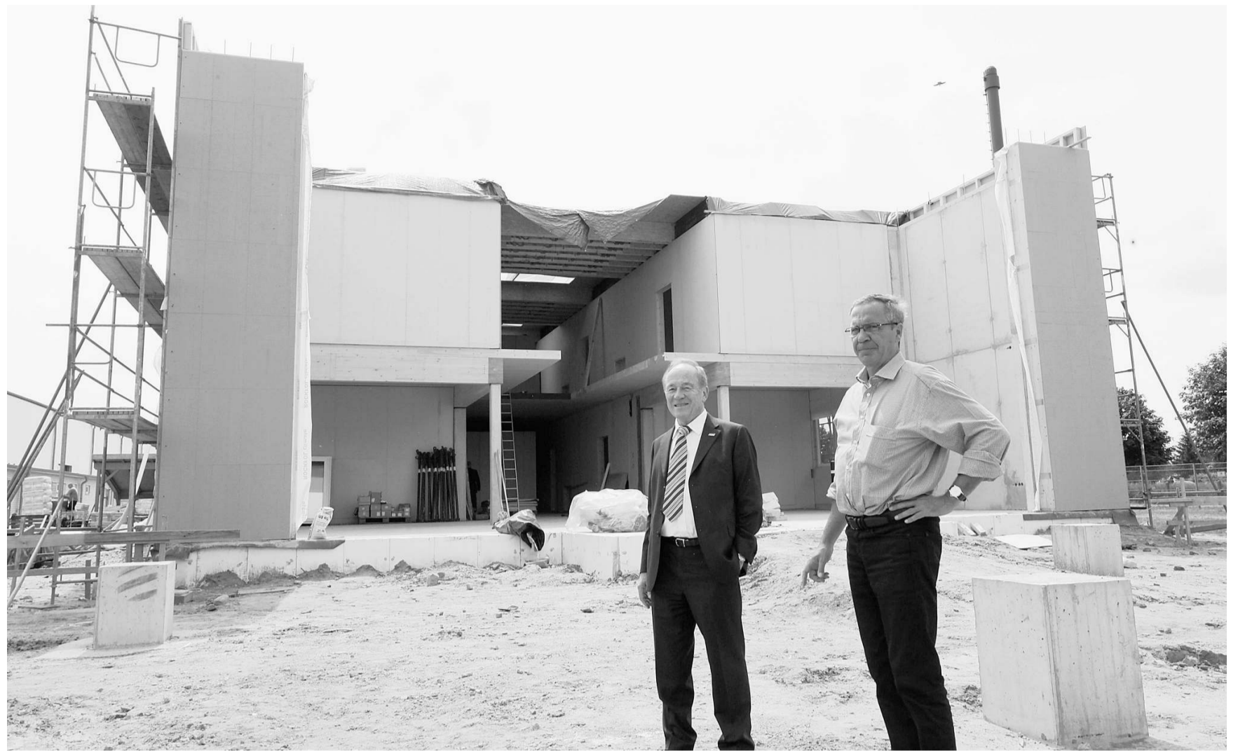
Firmenchef Martin Opitz (r.) mit einem Geschäftspartner an der Baustelle des neuen Verwaltungsgebäudes.
