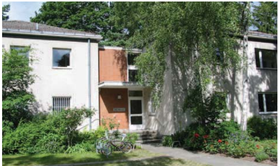
Bild 2 Der Baubestand: Ein L-förmiger, zweigeschossiger Wohnbau mit flachem Satteldach, der an dem Übergang der L-Schenkel von einem Treppenhaus erschlossen wird. Die Bauaufsicht forderte unabdingbar die Beibehaltung der Traufhöhe.
