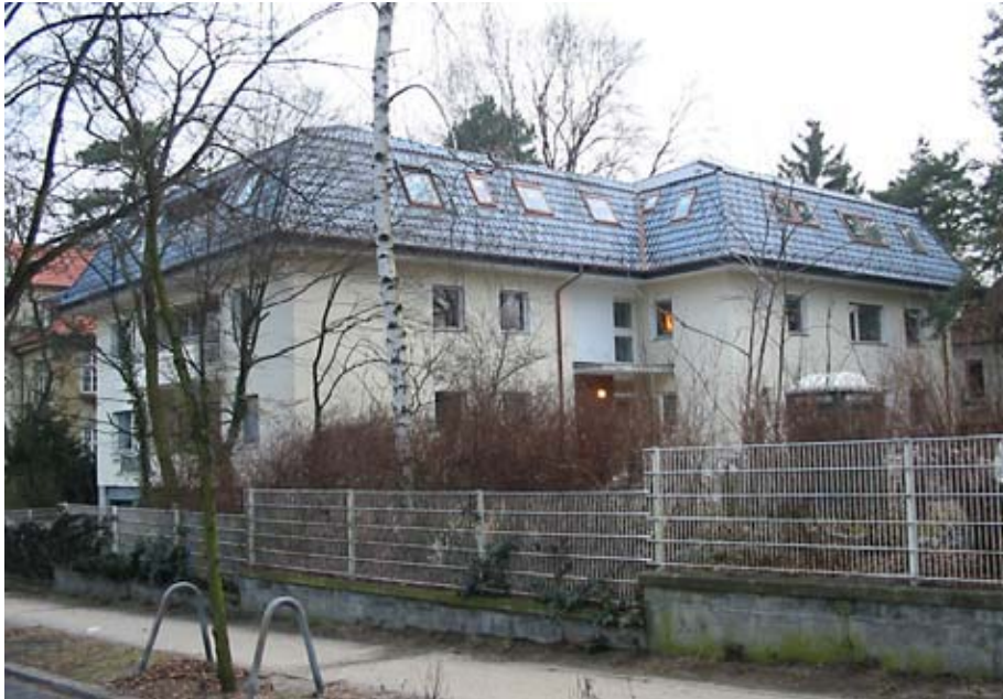
Bild 1: Die gefundene Lösung: Aufstockung mittels Mansardendach
