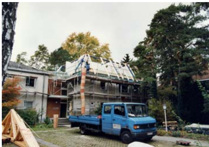
Bild 5 Auf den Innenwänden wurden die Riegel der Stahlrahmen abgelegt und genau nach den Sparren ausgerichtet. Dann erst wurden die Schrägstützen angeschweißt.
