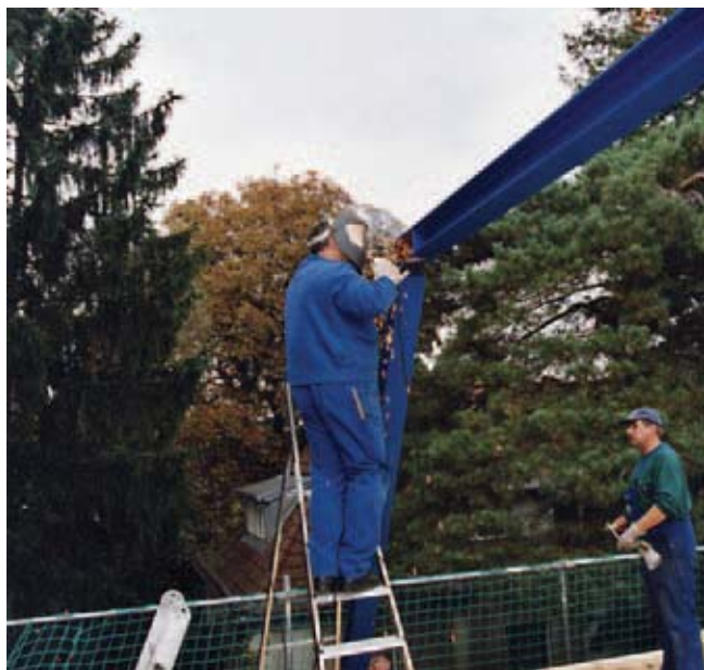
Bild 7 Baustellen-schweißung der Stahlrahmen, im Vordergrund nicht sichtbar lagert der Riegel auf den bereits gestellten Innenwänden.
