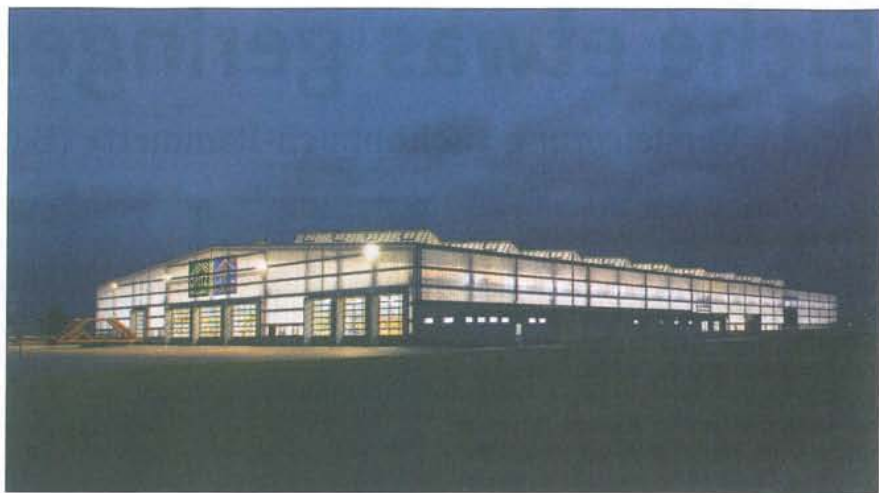
Die Nachtaufnahme zeigt die Lichtdurchlässigkeit der Fassade.
